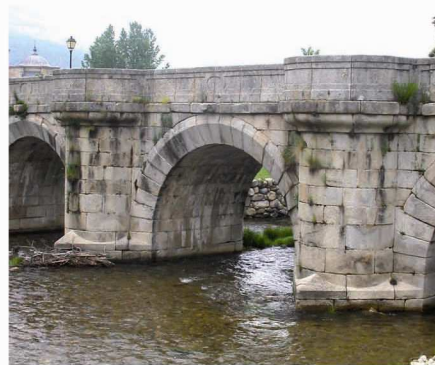
Puente del Perdón
